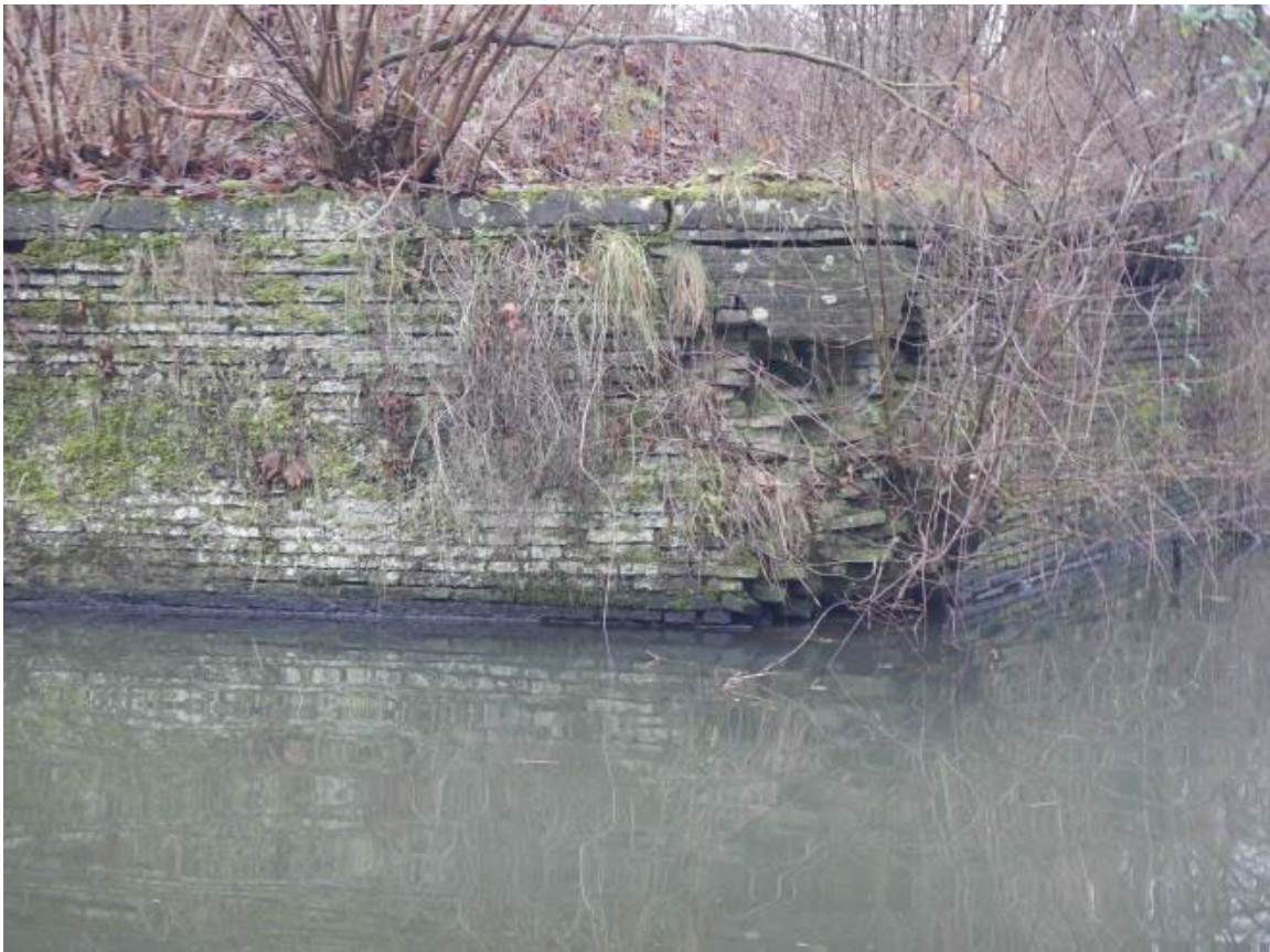
Bekledingsmuur Lunet II
