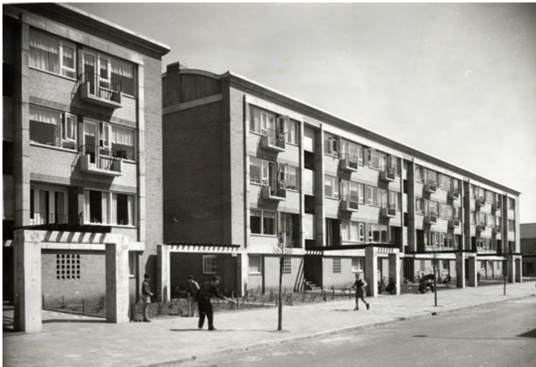
Gezicht op enkele flatwoningen aan de oostzijde van het Herderplein te Utrecht, met bijzondere betonnen
